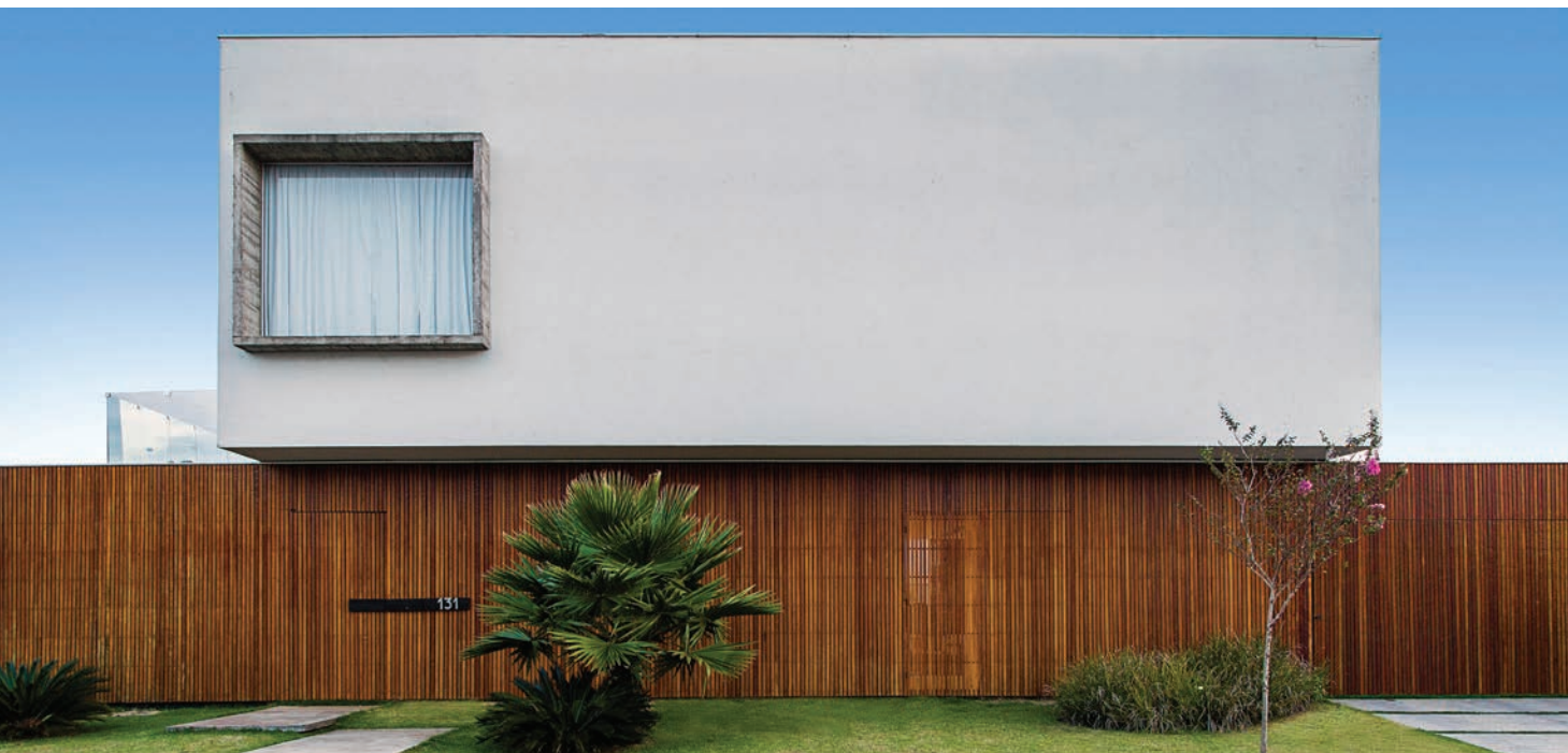
CASA C131. UMA OBRA SUSPENSA EM PLENA FORMA MAIS OUSADA DA ARQUITETURA.
