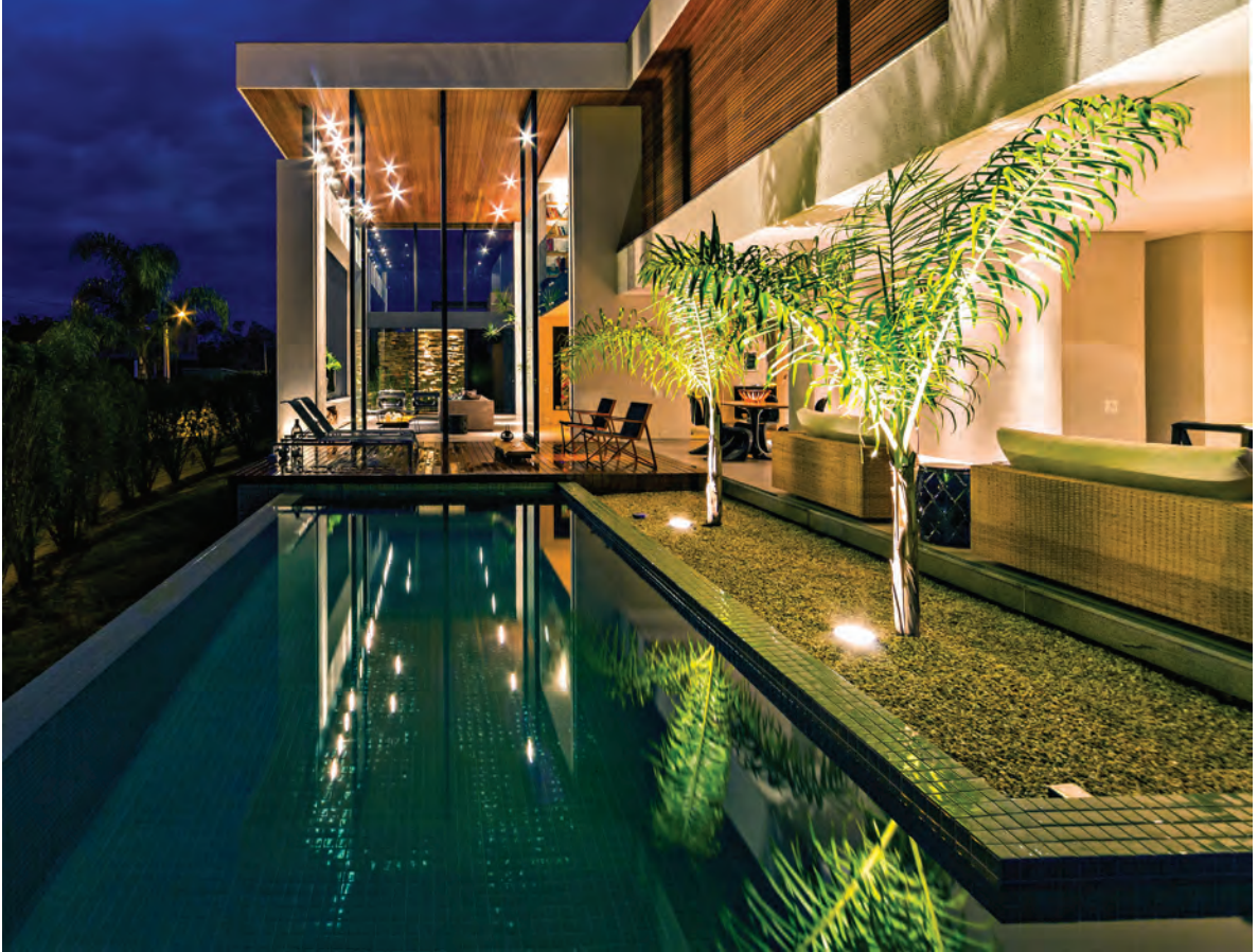
AS ESTRUTURAS VENCEM GRANDES VÃOS QUE APOIAM A COBERTURA E PARECEM FLUTUAR NA PAISAGEM, PAINÉIS DE MADEIRA DESLIZANTES CONTROLAM A ENTRADA DE LUZ.
